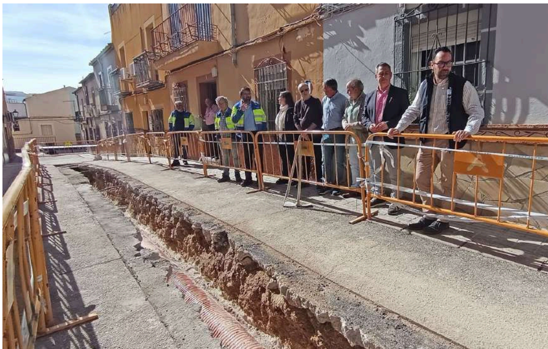
Obras en la calle Isaac Peral. / 5
