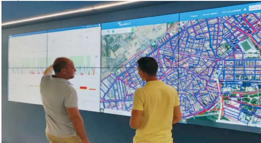
Uno de los Centros de Operaciones de Aqualia, donde se monitoriza e interpreta una gran cantidad de datos recogidos en las redes de agua. AQUALIA
