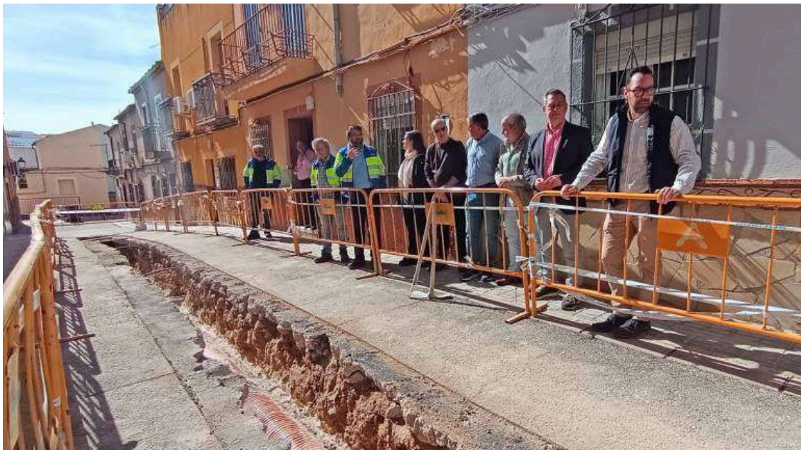
Visita a las obras de saneamiento de la calle Isaac Peral. / Ayuntamiento de Jaén.
